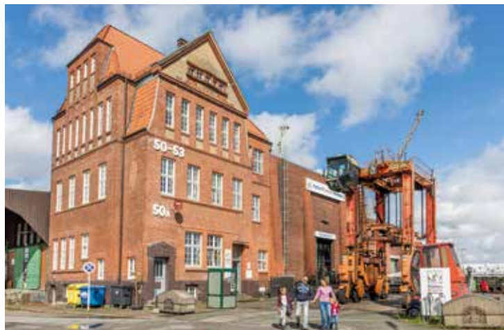
Kopfbau Schuppen 50 A des Hafenumuseums Hamburg. © SHMH, Foto: Sjinje Hashelder
